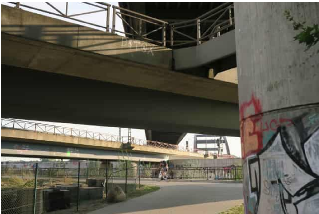
Brückenlandschaft an der Veloroute 9
